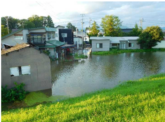
浸水被害の様子
