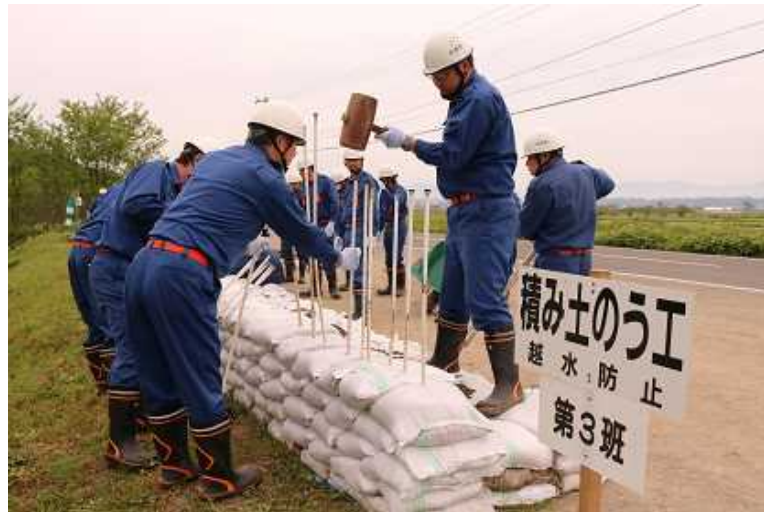
積み土のう工訓練
