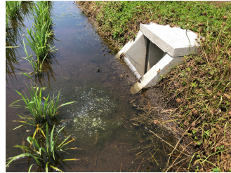
能代市河戸川・浅内地区
