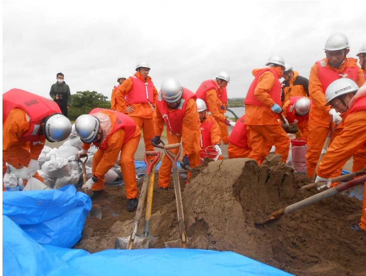
土のう作成の状況
