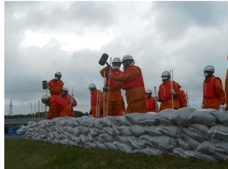
積み土のうの作成状況
