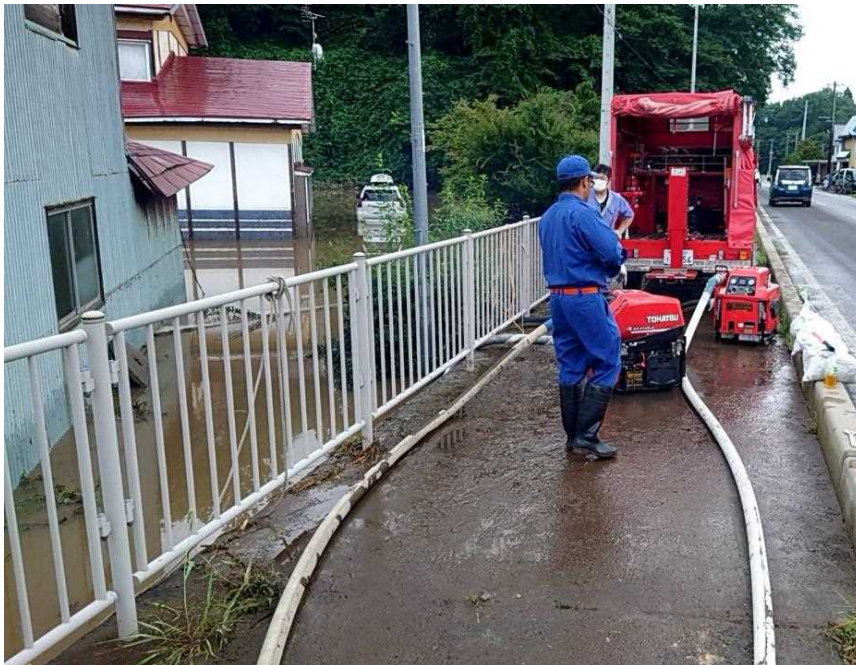
浸水現場での排水作業
