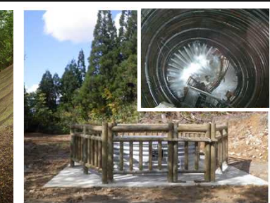
地すべり防止工
