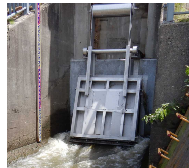
▲大林排水樋管(R3実施)
