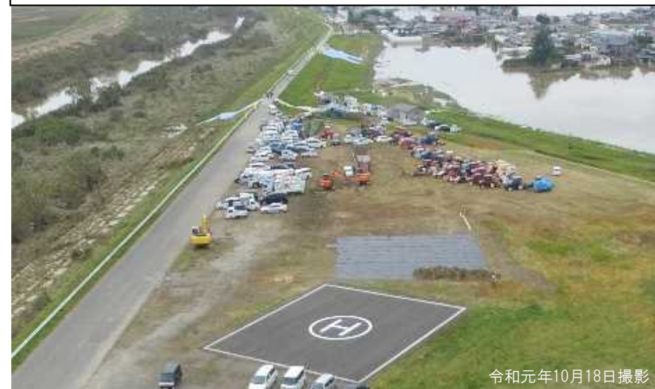
令和元年台風19号での水防災拠点への避難状況 宮城県大崎市（吉田川）
