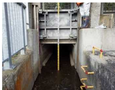
▲現況(ローラーゲート)
