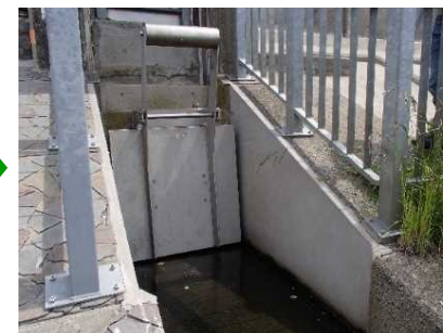
▲落合第4排水樋管
