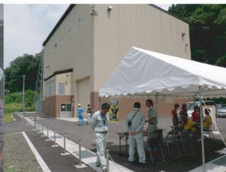
↑発電所は普段は無人の施設です
