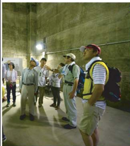
↑ダム探検隊「放流バルブ室の謎」
