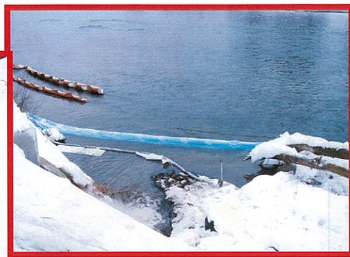
河川流出防止(オイルフェンス設置)
