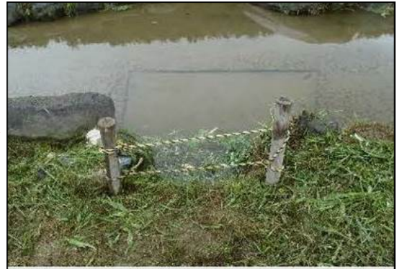
▲杭を打ち直し、トラロープを補強しました。
