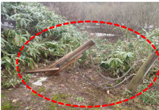
●立入禁止柵の破損
