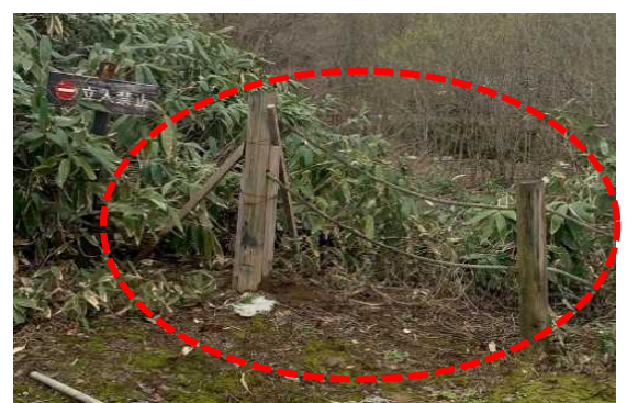
○立入禁止柵を補修しました
