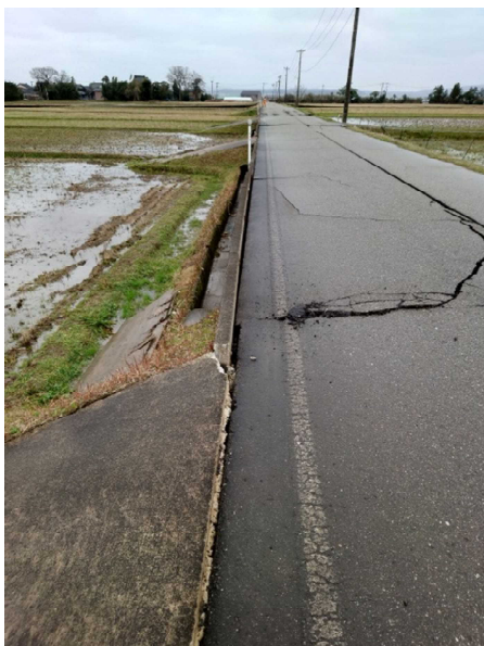
亀裂の延長計測
