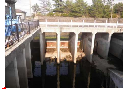
吸水槽スクリーンへの型枠合板貼付状況
