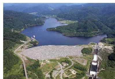
H19.8 堤体盛立完了
