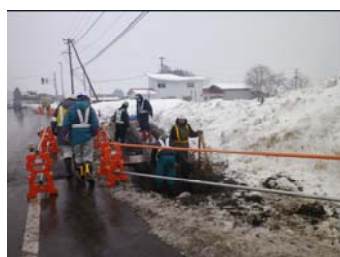
&lt;工事現場の点検・糠沢歩道&gt;
