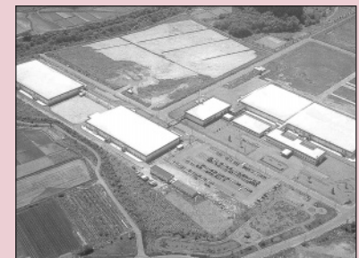
分譲が進む大館第二工業団地
