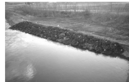
護岸補修(袋詰め根固め)
