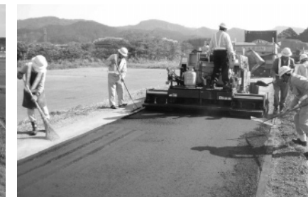
堤防上面補修状況
