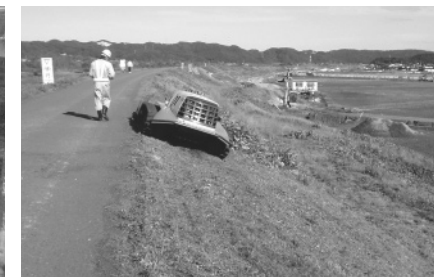
堤防除草状況(遠隔操作草刈機)
