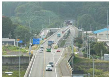
ニツ井高架橋
