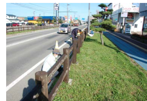
塗装作業の様子
