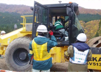
3D情報化施工機械の説明を受けています
