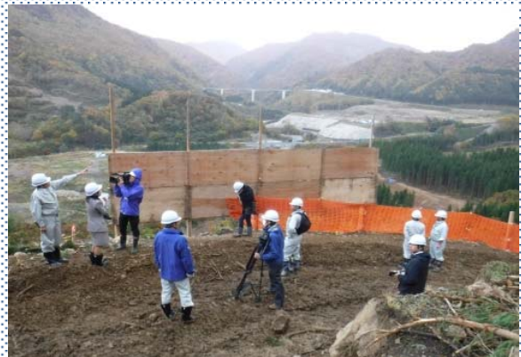
▲左岸から上流を望む
