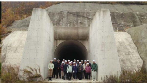
仮排水トンネル呑口前にて
