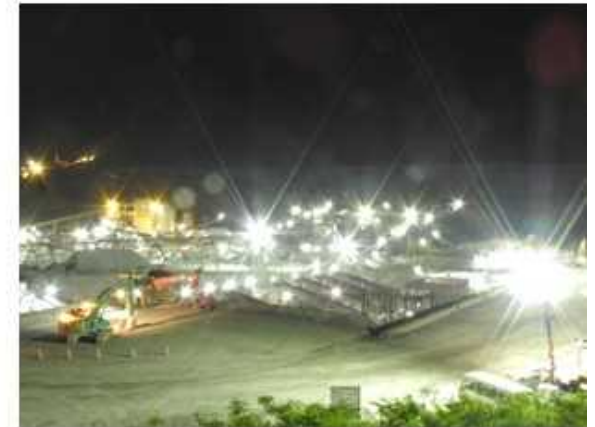
上流展望台から見たプラントヤード
