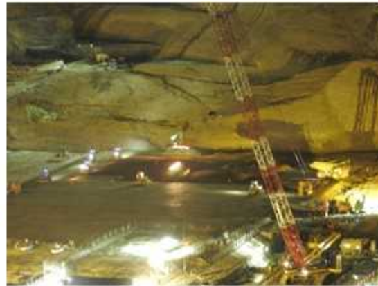
堤体打設状況
