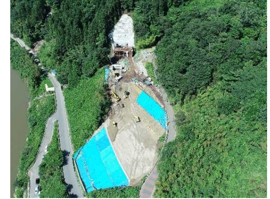
④ 橋梁下部工、道路土工(盛土)施工中
