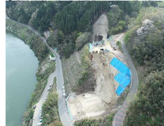
④ 橋梁下部工(第3号)、道路土工(盛土)施工中
