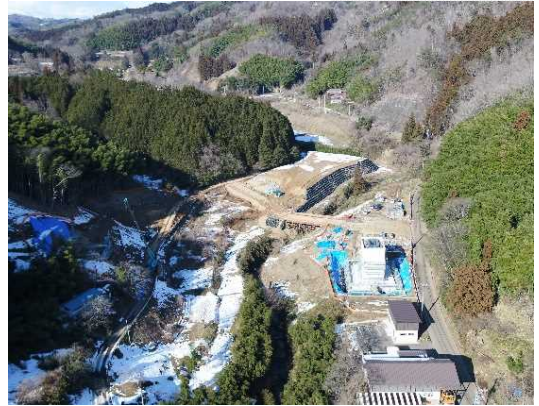
④ 橋梁下部工施工中(第2号橋)
