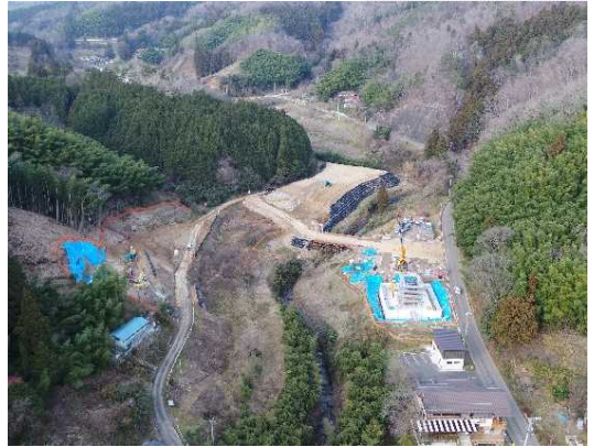
④ 橋梁下部工施工中(第2号橋)
