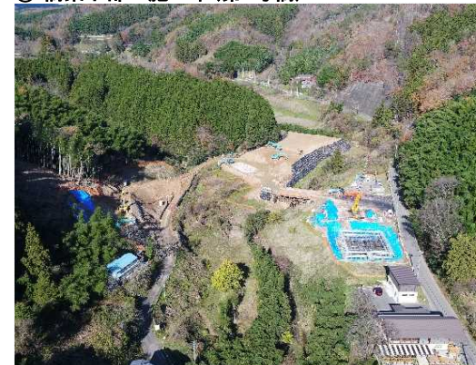
④ 橋梁下部工施工中(第2号橋)
