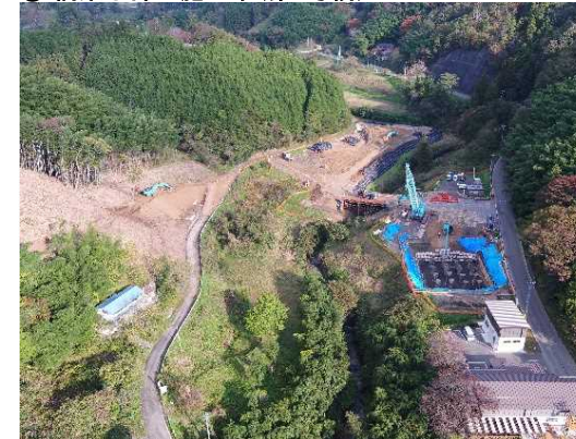
④ 橋梁下部工施工中(第2号橋)
