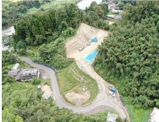
③ 法面工施工中
