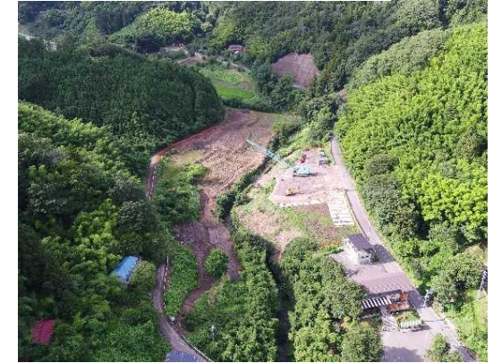
④ 橋梁下部工施工のためのヤード施工中
