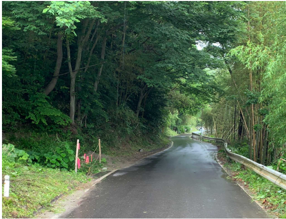
伊達市側から丸森市街地側を望む
