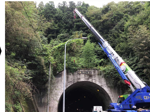
伊達市側から丸森市街地側を望む
