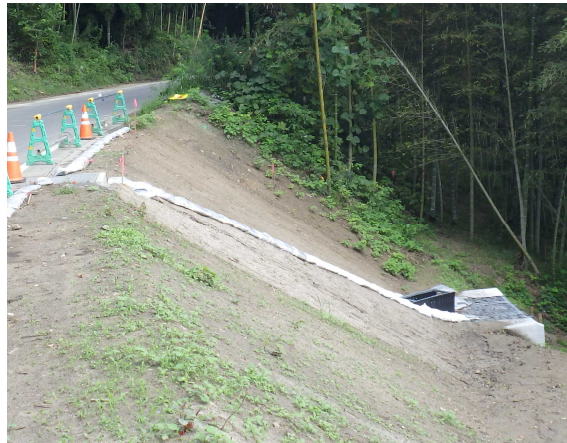
伊達市側から丸森市街地側を望む
