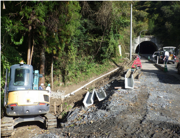
伊達市側から丸森市街地側を望む
