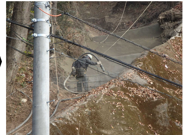
伊達市側から丸森市街地側を望む
