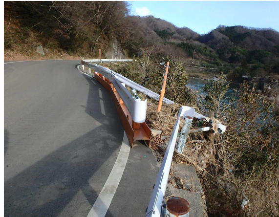
伊達市側から丸森市街地側を望む
