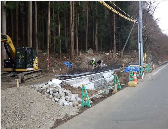
伊達市側から丸森市街地側を望む
