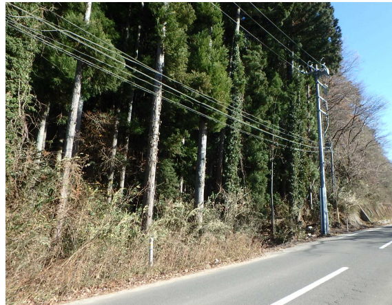
伊達市側から丸森市街地側を望む
