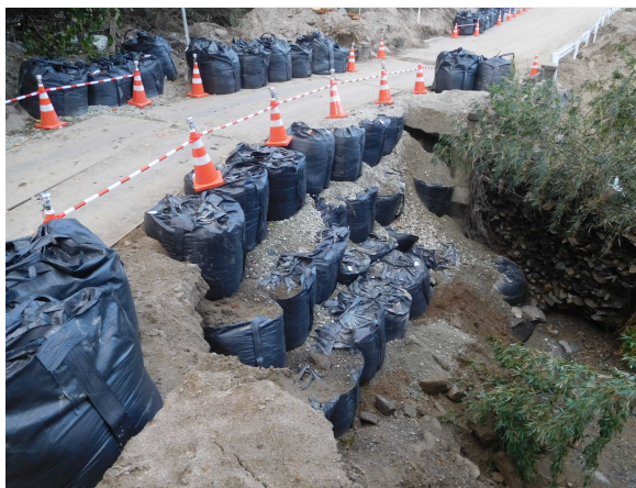
伊達市側から丸森市街地側を望む
