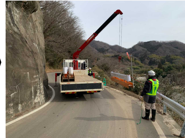
伊達市側から丸森市街地側を望む
