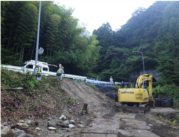
伊達市側から丸森市街地側を望む
