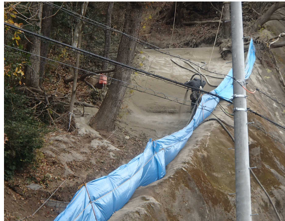
伊達市側から丸森市街地側を望む
