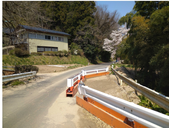
伊達市側から丸森市街地側を望む
