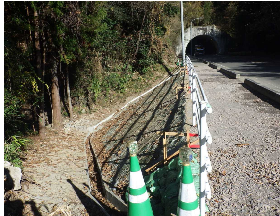
伊達市側から丸森市街地側を望む
