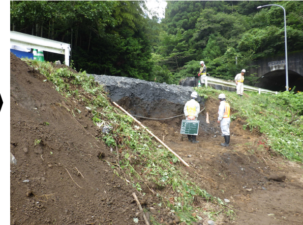
伊達市側から丸森市街地側を望む
