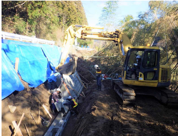
伊達市側から丸森市街地側を望む
