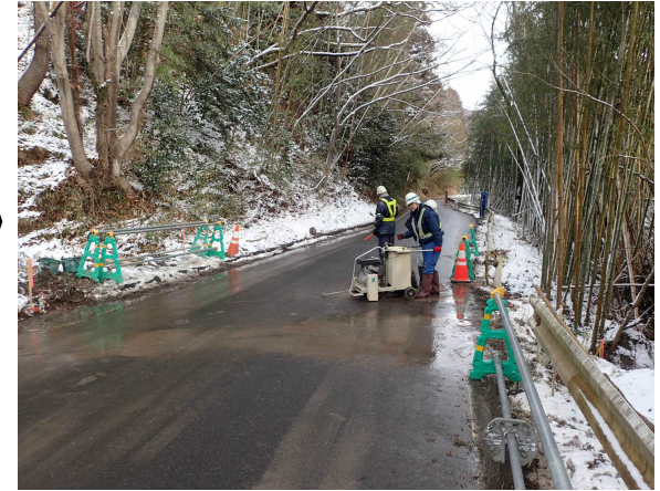
伊達市側から丸森市街地側を望む
