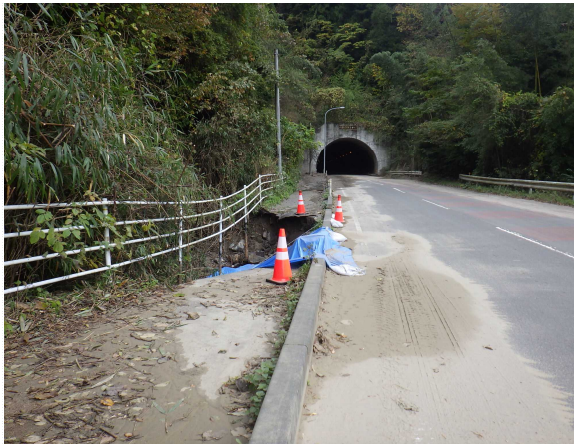
伊達市側から丸森市街地側を望む
