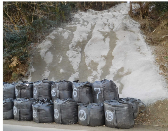
川側から山側を望む
