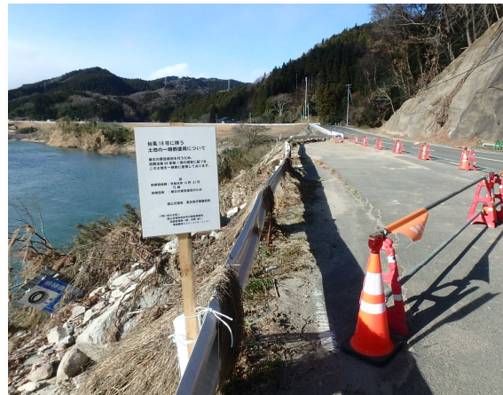
丸森市街地側から伊達市側を望む
