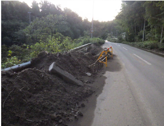
丸森市街地側から伊達市側を望む
