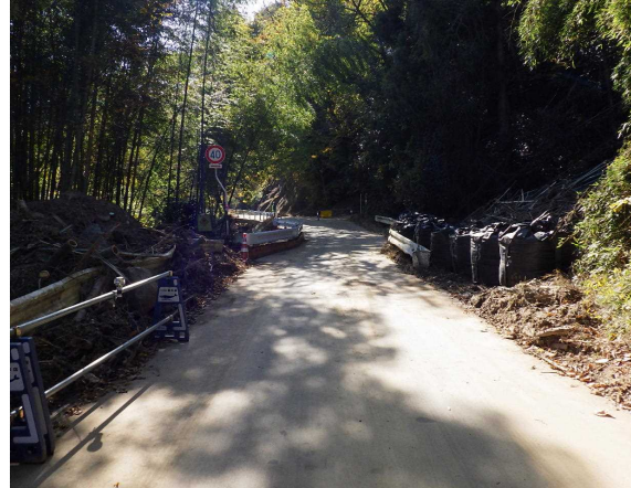
丸森市街地側から伊達市側を望む
