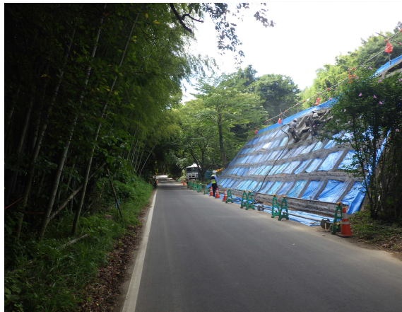
丸森市街地側から伊達市側を望む
