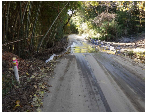
丸森市街地側から伊達市側を望む
