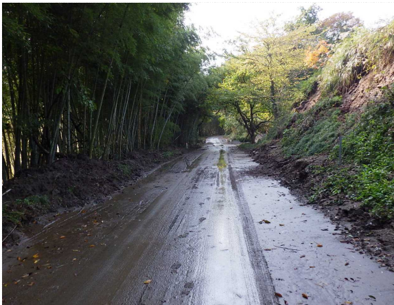
丸森市街地側から伊達市側を望む
