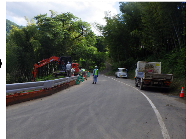
丸森市街地側から伊達市側を望む
