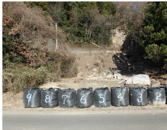
川側から山側を望む
