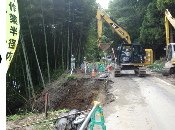
丸森市街地側から伊達市側を望む
