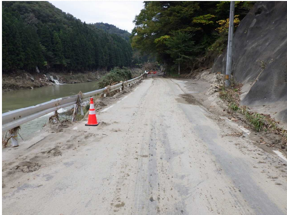
丸森市街地側から伊達市側を望む
