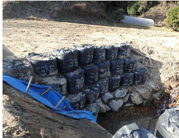
川側から山側を望む
