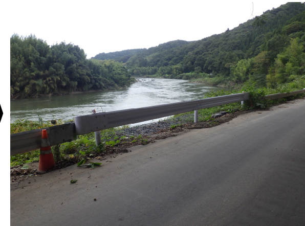
丸森市街地側から伊達市側を望む
