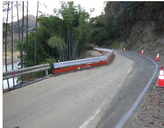
丸森市街地側から伊達市側を望む
