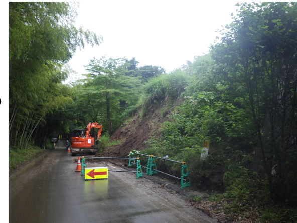
丸森市街地側から伊達市側を望む
