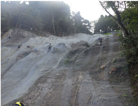
川側から山側を望む
