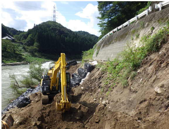
丸森市街地側から伊達市側を望む
