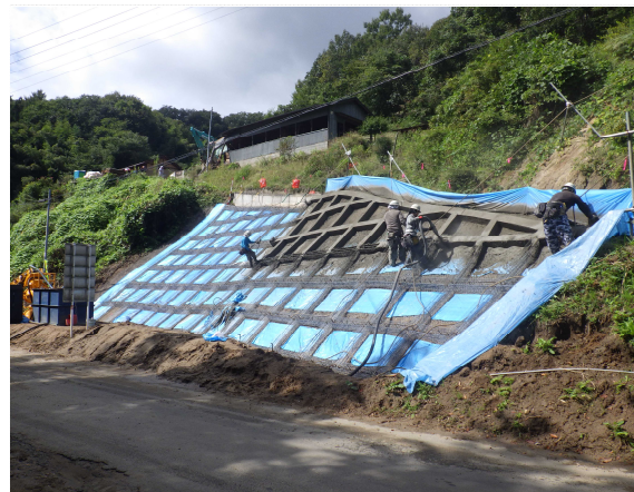
丸森市街地側から伊達市側を望む
