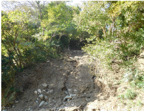
川側から山側を望む
