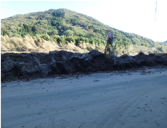
丸森市街地側から伊達市側を望む
