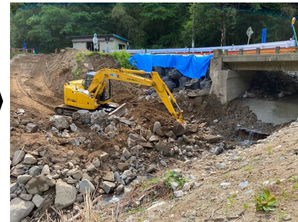
丸森市街地側から伊達市側を望む
