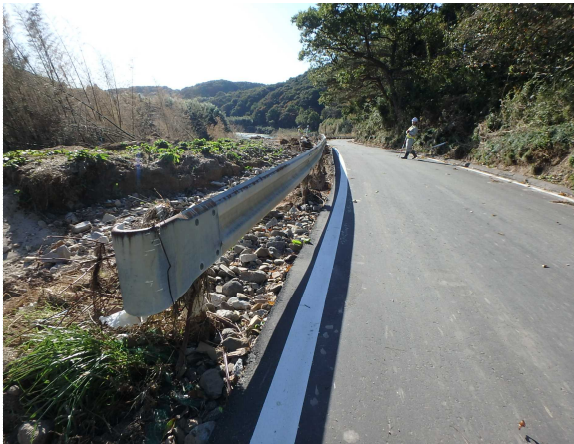
丸森市街地側から伊達市側を望む
