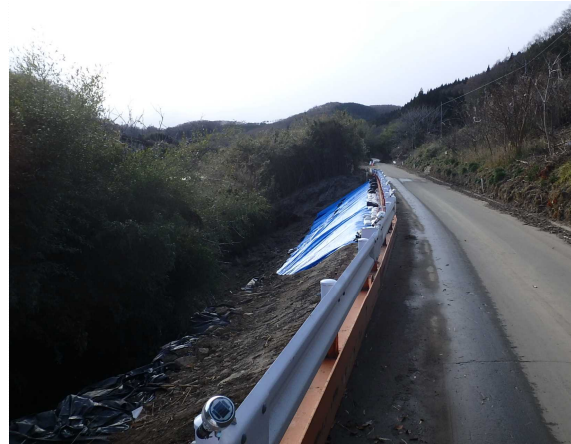
丸森市街地側から伊達市側を望む
