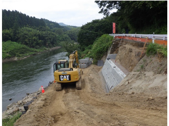
丸森市街地側から伊達市側を望む
