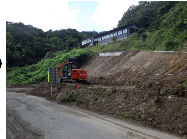
丸森市街地側から伊達市側を望む
