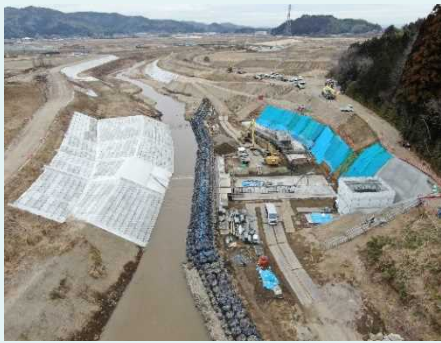
河川災害復旧事業 (内川上林東地区：山下堰)
