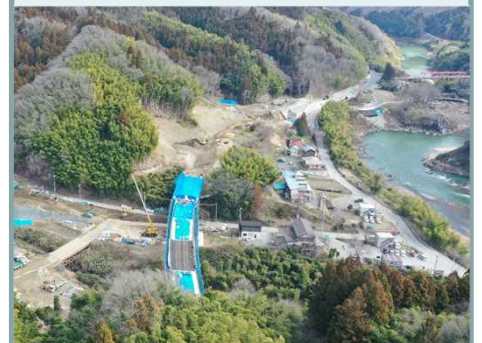
国道349号 丸森地区災害復旧事業 (丸森町耕野地区)
