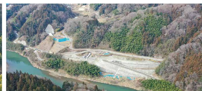
施工状況④ 終点部（丸森町大張川張地区）
