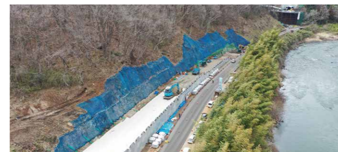
施工状況① 起点部（丸森町耕野不動地区）
