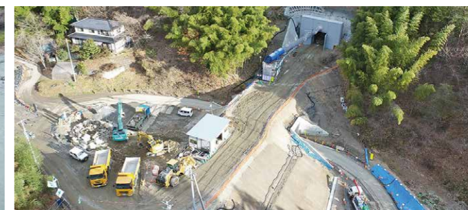
施工状況②（仮）第2号トンネル
