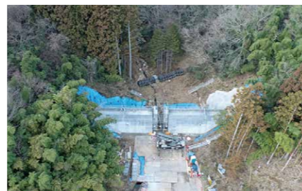
▲新設工事（大畑沢砂防堰堤）
