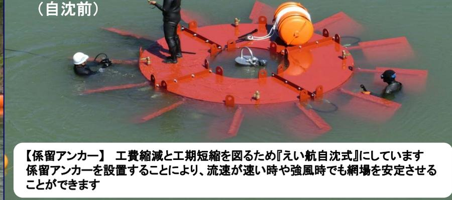
【係留アンカー】 工費縮減と工期短縮を図るため『えい航自沈式』にしています
