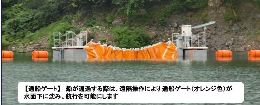
【通船ゲート】 船が通過する際は、遠隔操作により通船ゲート(オレンジ色)が水面下に沈み、航行を可能にします
