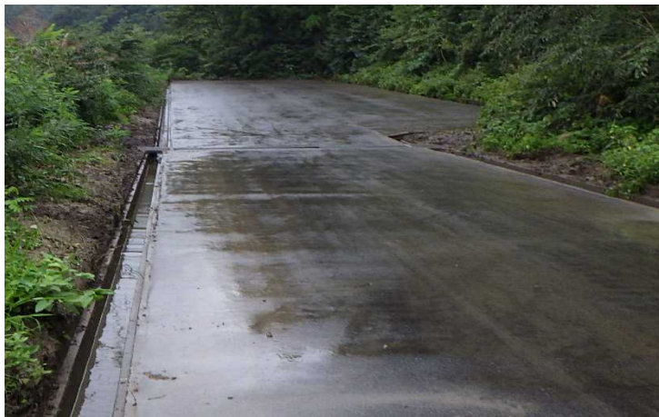
【合地沢湖面広場駐車場】 土砂撤去後の通路と 駐車場の状況
