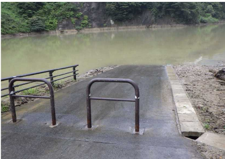
【合地沢湖面広場】 土砂撤去後の水面までの アプローチ部の状況
