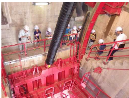
（機械設備の点検）
