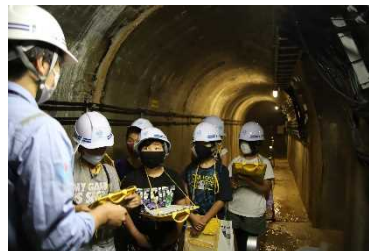
（堤体内での点検・計測）
