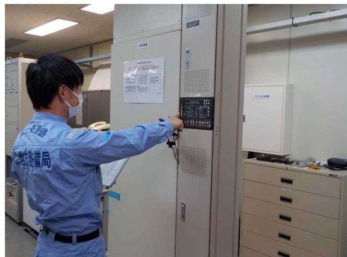
管理施設の点検状況(無線設備)
