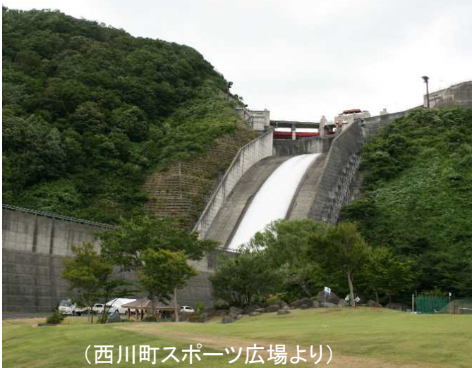
寒河江ダムゲート放流状況
