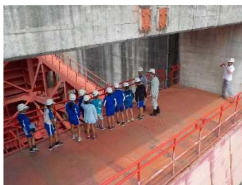
（放流ゲートの巡視・点検）
