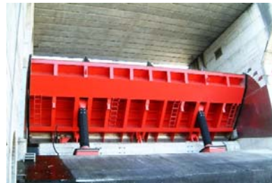
ゲート下流側から
