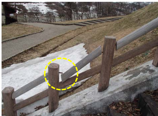
↑点検時の状況
