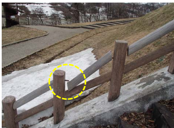
↑点検時の状況
