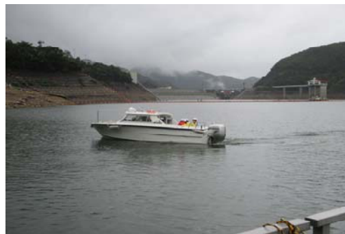
（巡視船による貯水池巡視）
