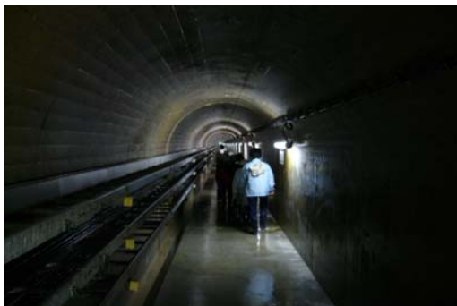
（監査廊内の点検）
