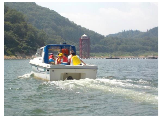
（巡視船による貯水池巡視）
