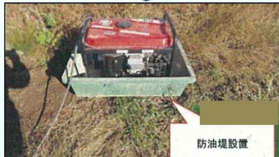
油漏れ対策として防油堤を設置した。
