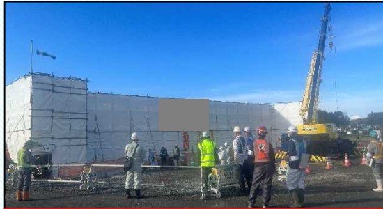
施工箇所(ボックスカルバート)の点検。
