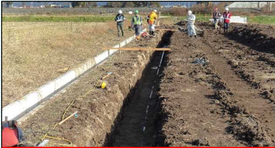
施工箇所(排水構造物工)の点検。
