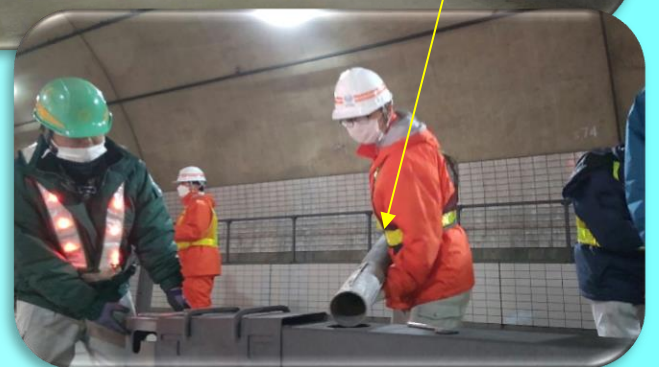
↑ トンネル内にて大規模事象が発生した際は、支柱を1本1本抜き取って、Uターンできるように中央分離帯に開口部を設けます。
