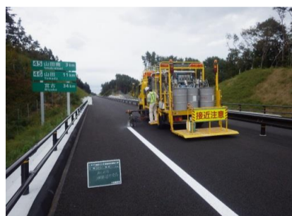
区画線の施工状況
