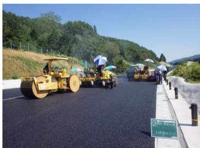
アスファルト舗設状況
