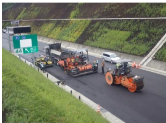
アスファルトコンクリート舗装状況(本線)
