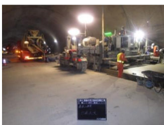
連続鉄筋コンクリート舗装状況
