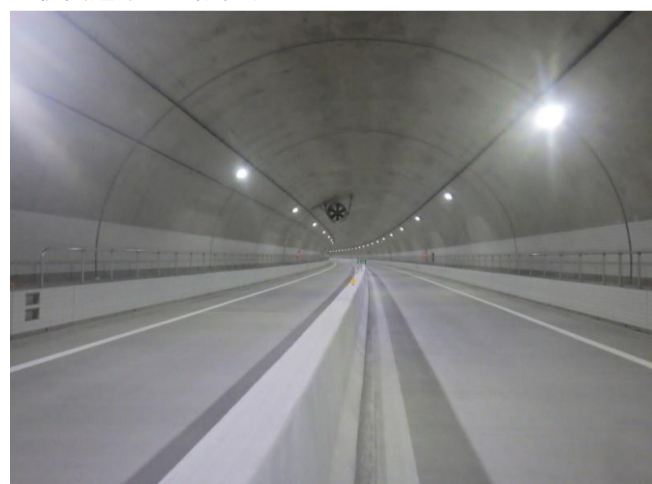
大槌第二トンネル 完成
