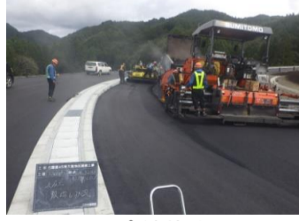
ランプ 舗装状況
