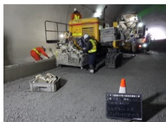
円形水路生コン打設状況
