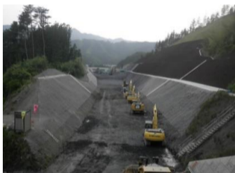
排水構造物岩削状況
