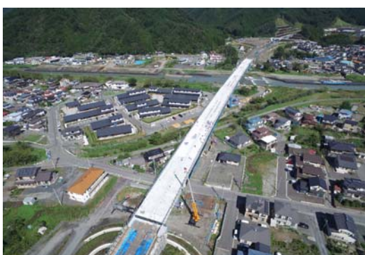
ドローンで現場見学会状況撮影
