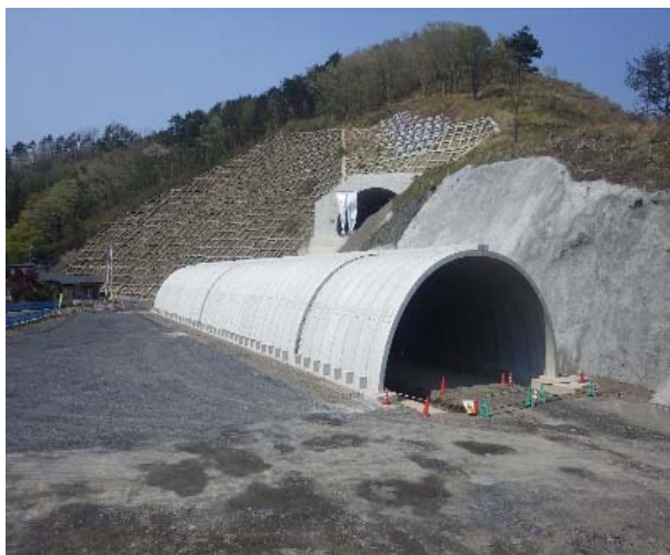
小槌工区 アーチカルバート工・護岸工
