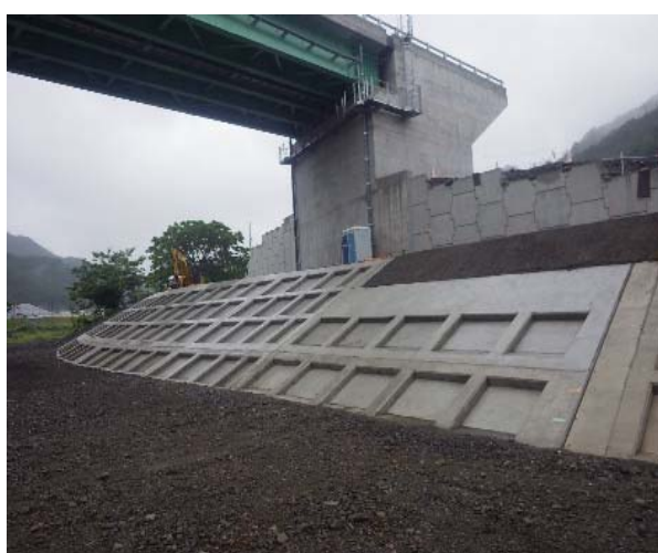
小槌工区 アーチカルバート工・護岸工
