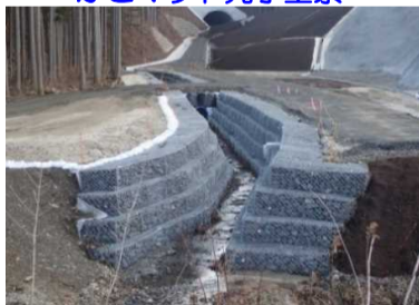
No.653～No.656 かごマット完了全景
