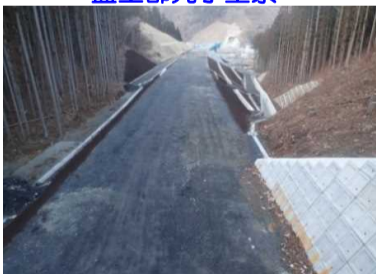
No.643～No.650 盛土工完了全景
