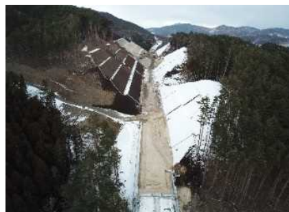
大沢地区切土部完了全景
