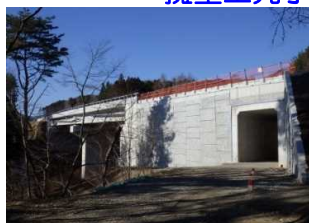
擁壁工完了全景
